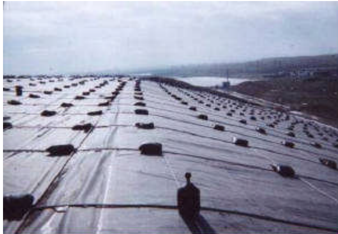
Yolo County Landfill (CA)
